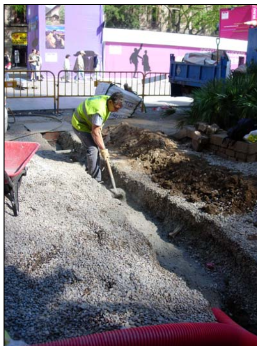
FOT. 2: Vista de l'obertura nord de la rasa efectuada al sector 1, on s'observen les canalitzacions de fibra òptica.
