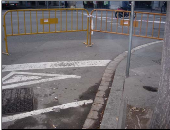
FOT. 11: Vista general de la zona d'actuació (sector 3) abans de comença l'excavació de la rasa.
