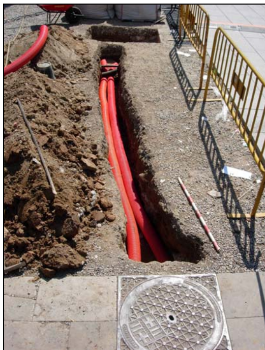
FOT. 1: Vista de l'obertura sud de la rasa efectuada al sector 1 durant els treballs d'excavació.
