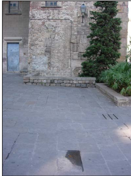
FOT. 9: Vista general de la zona d'intervenció (sector 2) abans de començar l'excavació de la rasa.
