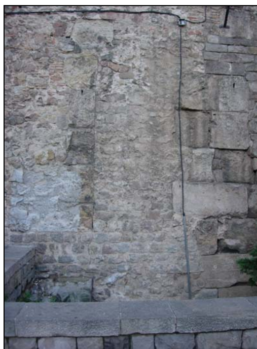
FOT. 4: Vista de la part sud de la rasa realitzada al sector 1, amb les canalitzacions de fibra òptica.
