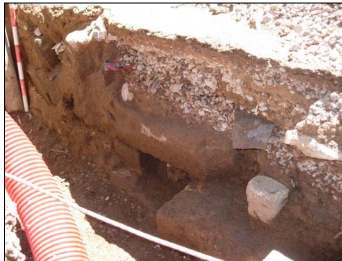
FOT. 6: Vista del rebliment de la muralla del S.IV d.C., localitzat al nord del sector 1. Es pot observar la canalització que desguassava l'aigua cap a l'exterior de la ciutat.
